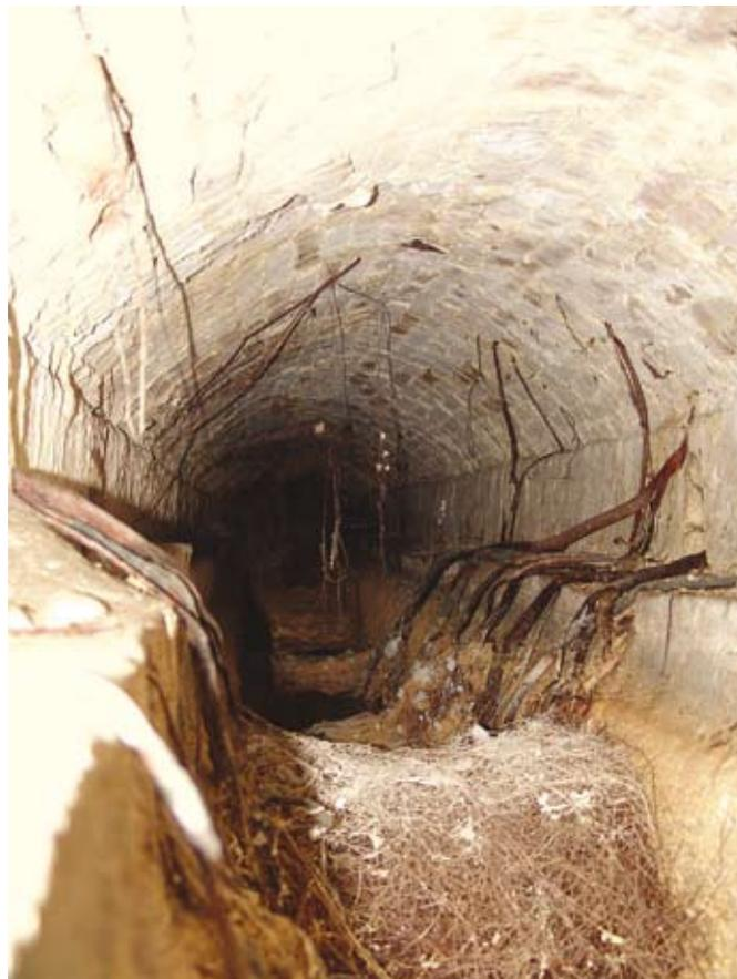
Fig. 34 - Fonte Brecciola, cunicolo interno con infiltrazioni di radici (foto A. De Ascentiis).
