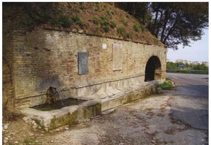
Fig. 29 - Fonte Pila, facciata fontana dove sono visibili le modifiche apportate nel corso degli anni - tracce di più cannelli lungo il lavatoio, ingresso del cunicolo obliterato e lapide con poesia del Prof. L. Illuminati (foto A. De Ascentiis).
