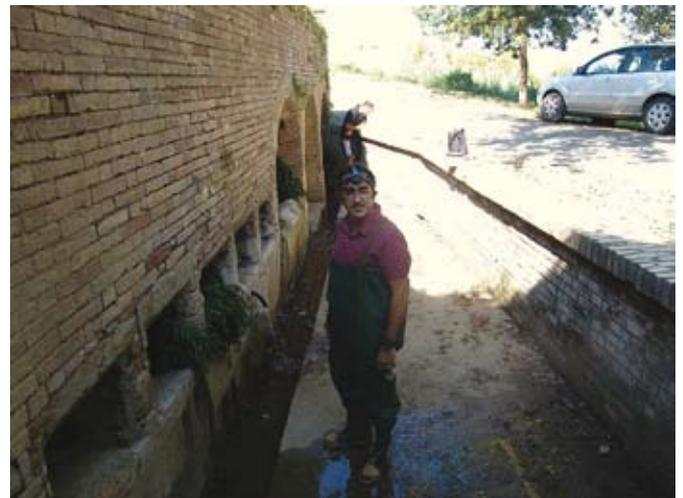
Fig. 22 - Fonte Fontecchio, esterno fontana, visibili parte superiore in laterizio e parte sottostante in blocchi di pietra serena (foto A. De Ascentiis).
