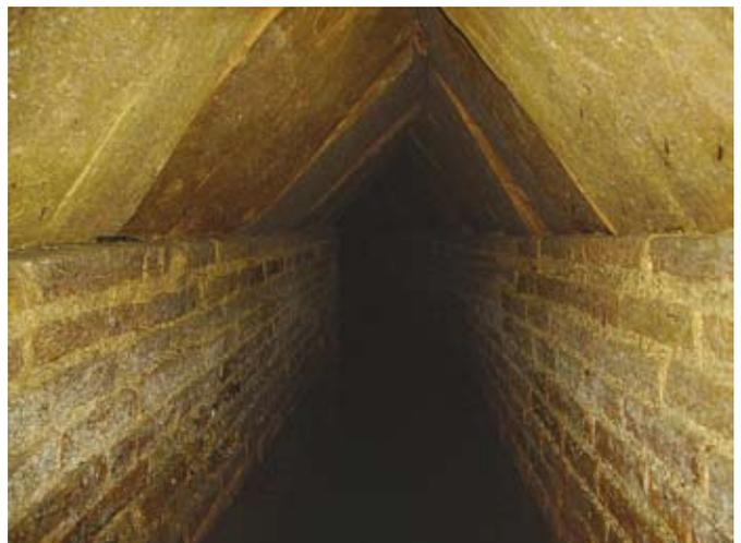
Fig. 14 - Fonte Argentina, cunicolo principale costituito da muri in laterizi e tetto in "tavelloni mammellati" (foto A. De Ascentiis).
